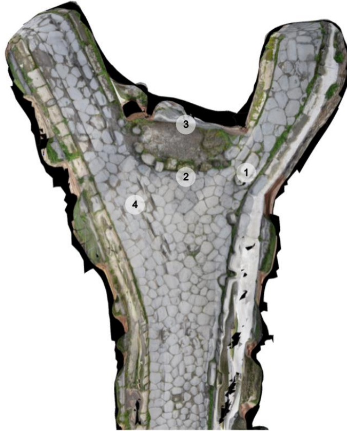
INTERSECTION A: Via Consolare, Vico del Farmacista, and Vicolo di Modesto
