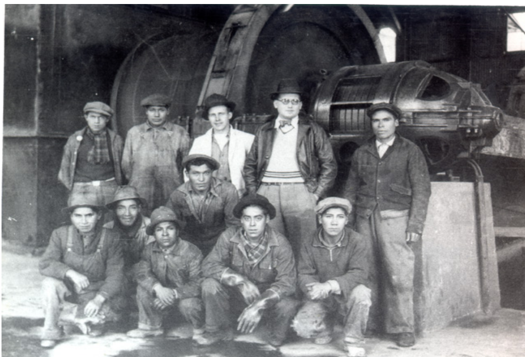
Fig. 10 Obreros y funcionarios frente a la compresora, 1935. Repositorio online de la PUCP
