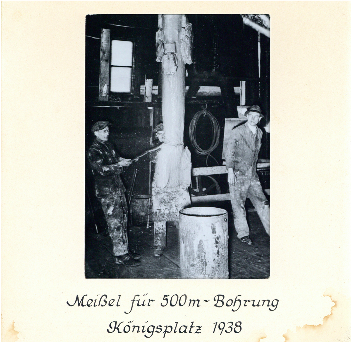
Fig. 16. Chisel for a 500 meter drilling at the Königsplatz in Berlin. 1938. Berliner Unterwelten e.V. 61
