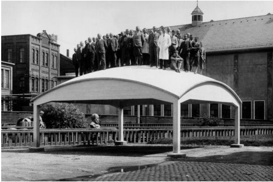
Fig. 31. Demonstrative test-loading of a prestressed concrete ceiling designed by Dywidag. 1930s. Bolle, Guido, et al. “Geschichtliche Entwicklung und aktuelle Praxis der Probelastung – Teil 1: Geschichtliche Entwicklung im 19. Und Anfang des 20. Jahrhunderts.” Bautechnik , vol. 87, 2010, fig. 23, p. 705. 82
