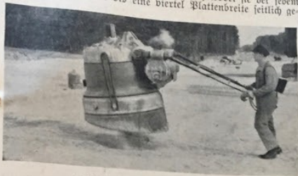
Abb. 4. Delmag-Frosch 2,5 t. Aufn.: Degebo (Reumann).
