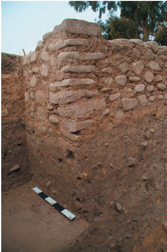
Figura 3.4 ASD 23, un muro histórico.
