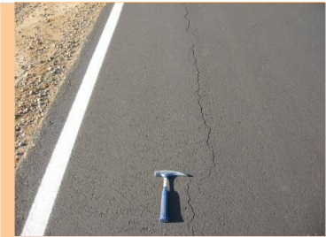
Longitudinal crack
