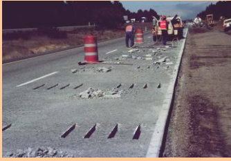
Dowel bar retrofit
