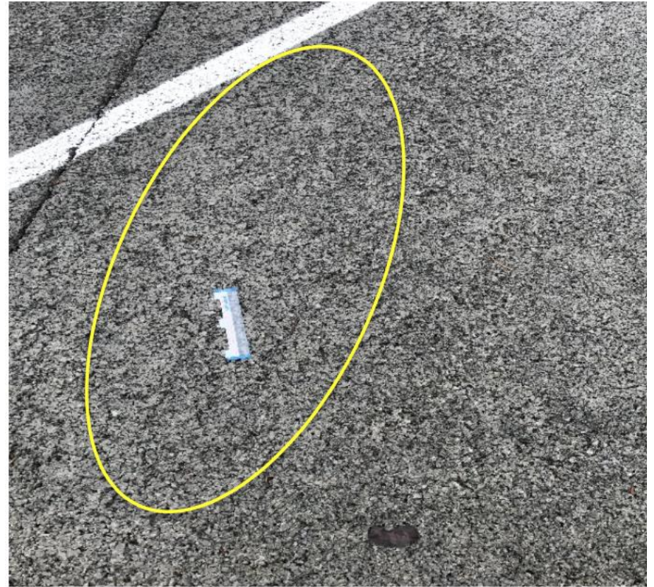
b) Longitudinal Cracking
