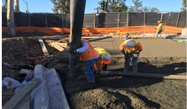
b) Pouring of concrete
