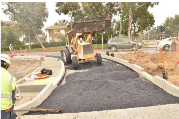
a) Pouring of asphalt mix
