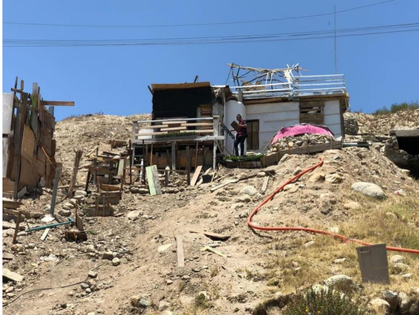
Ilustración 3: Casa en una comunidad irregular en una zona de riesgo en Tijuana. Foto de archivo, Diario El Imparcial . “Es irregular 60% de nuevas viviendas en Tijuana: Colegio de Ingenieros Civiles de Tijuana.”
