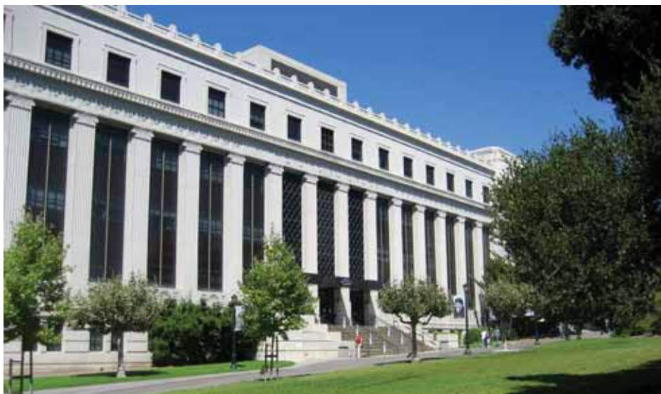
图 1.59 加州大学伯克利分校的生命科学大楼。(谌谟美摄) Figure 1.59 Valley Life Science Building, UC Berkeley campus. (Chen Momei)
