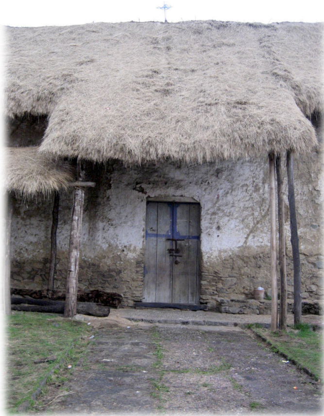
Figure 16: The Entrance to La Iglesia de San Francisco de Asis de Marcapata
