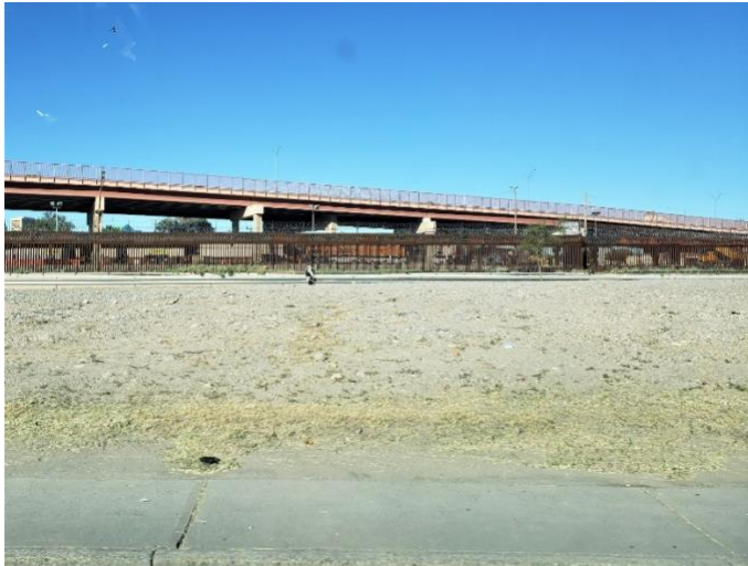
Fig. 7 Frontera Ciudad Juárez / El Paso, con valla y autopista elevada; fotografía: Peter Krieger, 22 de septiembre de 2022
