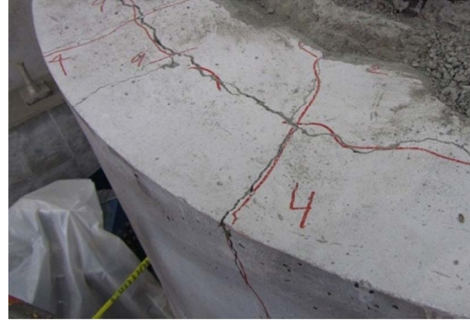
(d) Top of the shaft (south side)
