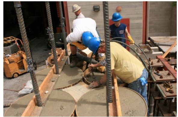
(d) Concrete pour
