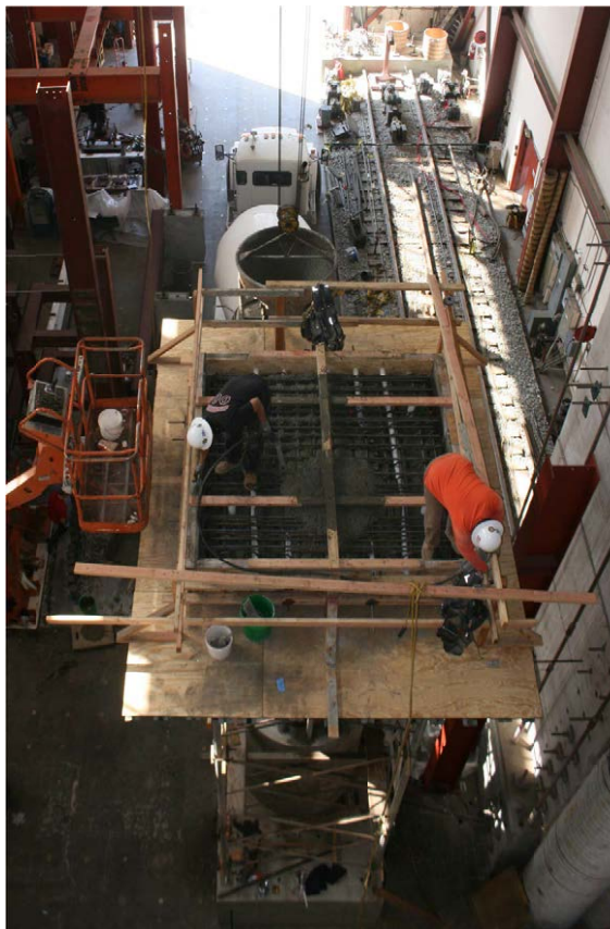
Figure B.18: Concrete pour of the load stub (Pour 5)
