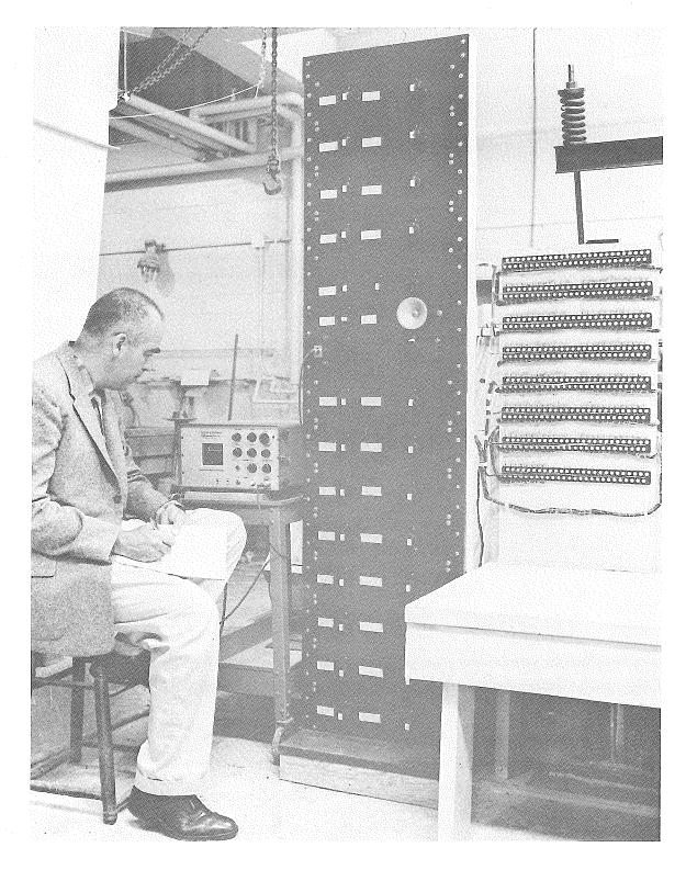
FIGURE 19 - ARRANGEMENT OF STRAIN GAGE RECORDING EQUIPMENT
