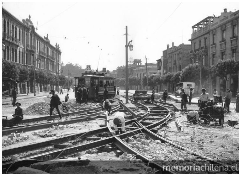
Fig. 6. Trabajos en las líneas del tranvía eléctrico, Alameda desde Plaza Italia, 1927.
