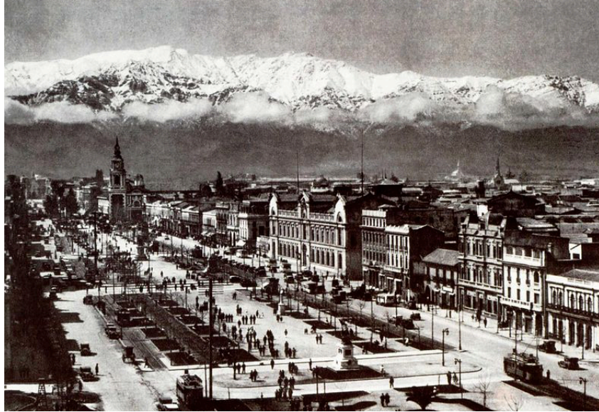
Fig. 1. Vista hacia la Alameda, 1930.
