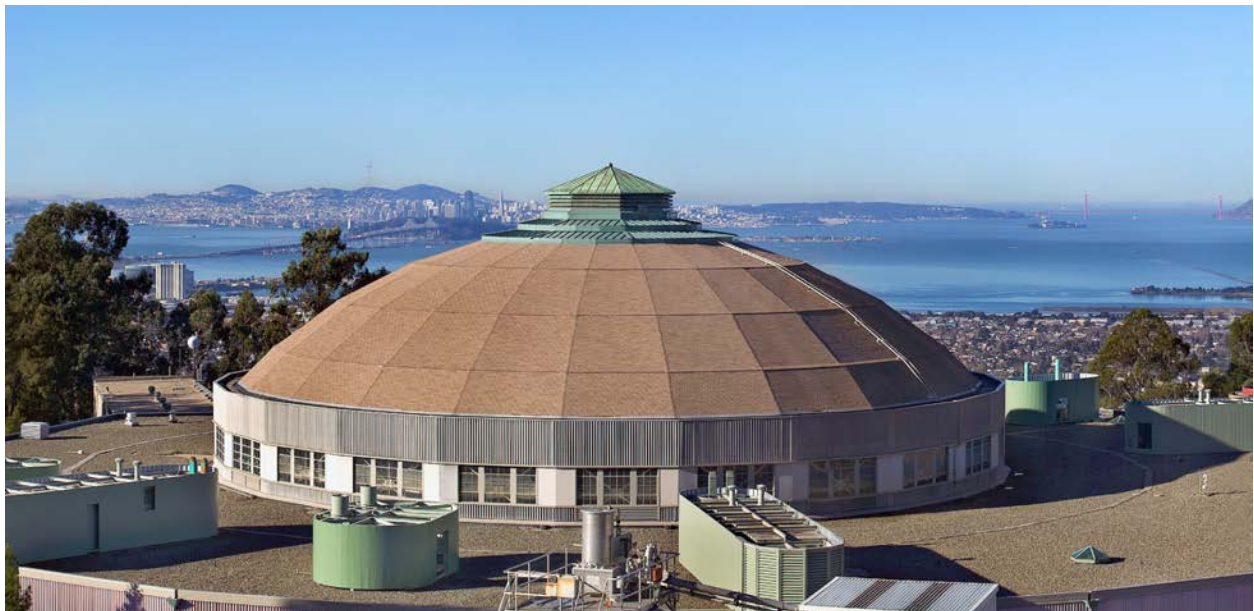
Figure 2. The ALS building at LBNL.
