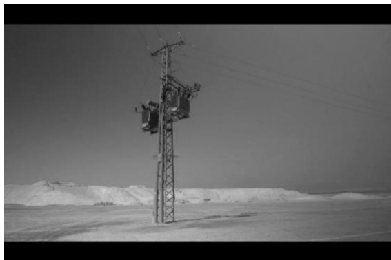
图1 《天坑》中以远景拍摄的电线塔， 背景为堆积的盐山
