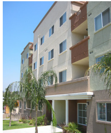
Figure 10: 306 N. Alvarado St., side view
