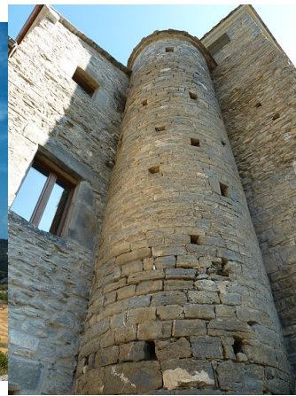
Castillo de los Mur. Formigales (Huesca). 15 th c.
