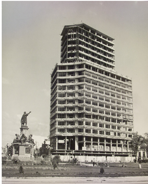
Figure 2.1: The building of the Secretaría de Recursos Hidráulicos, circa 1950 (Instituto de Investigaciones Estéticas, UNAM).
