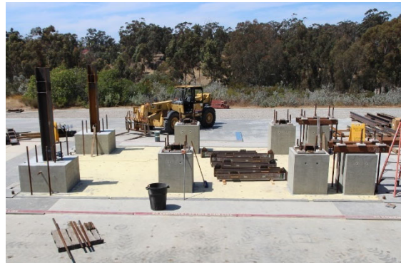
(d) Placement of Pin-supports for Gravity Columns
