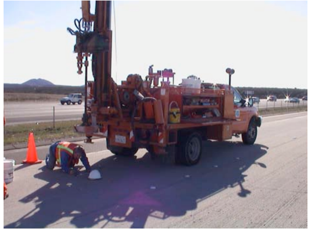
b. Coring rig
