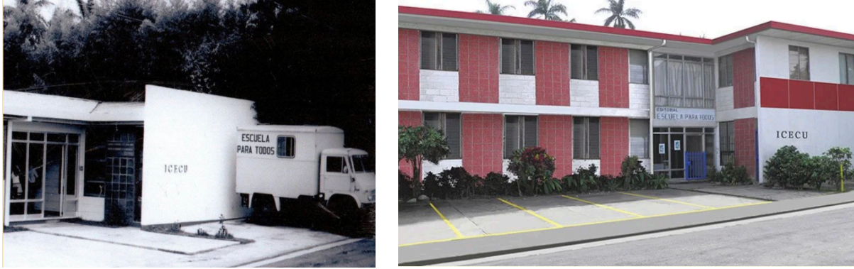
Fig. 43. Sede central del ICECU: testimonio de la evolución arquitectónica y la solidez estructural del proyecto. (A) Izquierda: Edificio original del ICECU junto a un camión de la organización hermana; (B) Derecha: El mismo edificio en la actualidad. Fuente: Adaptado de la Fundación Escuela para Todos y del ICECU.
